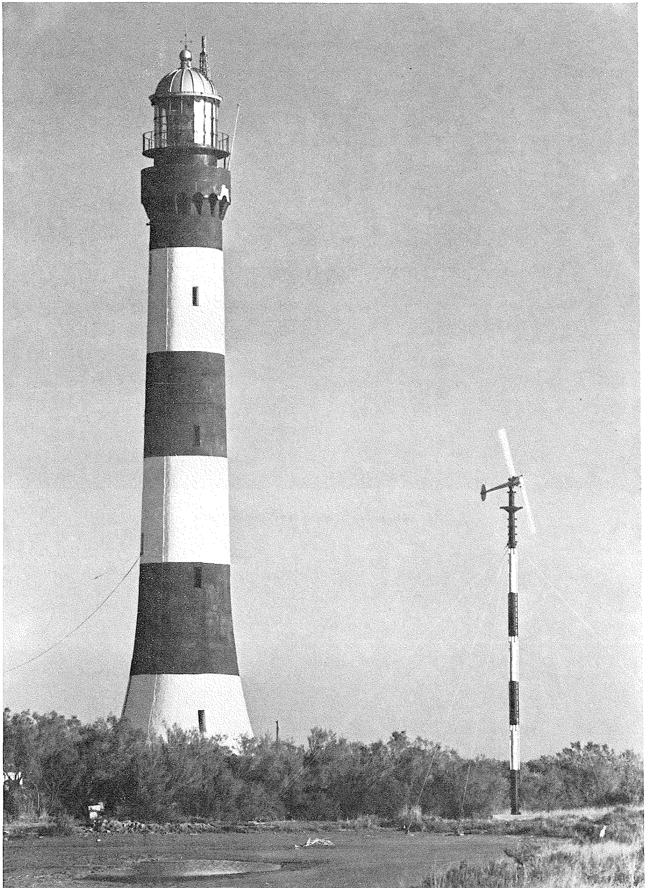
15/ Le phare de Faraman (Bouches-du-Rhône) alimenté par un aérogénérateur « Aérowatt » de 1 100 W
